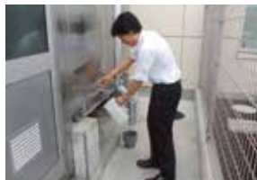
リザーバータンク機能付の受水槽
