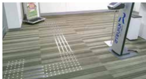
店内の点字ブロック
