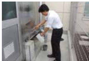
リザーバータンク機能付の受水槽
