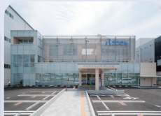
清水支店 清水ローンセンター (1958.2.15開設)
